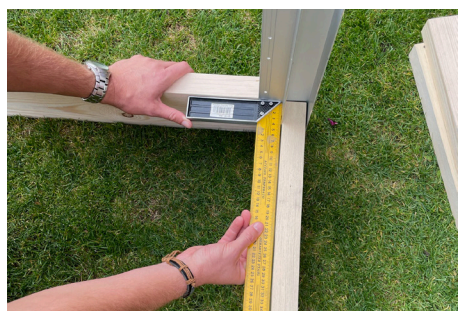
4. Toto opakujte pre všetky 4 rohy a zostavte prvý rad záhona. Kolmost' rohov overte uholníkom.
