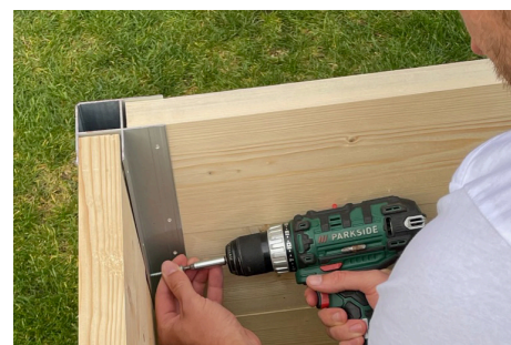
6. Dbajte na to, aby medzi fošňami nezostali medzery. Najlepšie to pôjde poklepaním na hornú hranu gumovou paličkou.
