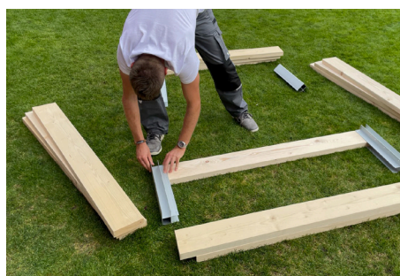
2. Uistite sa, že je fošňa dôkladne dorazená v hliníkovom rohu.
