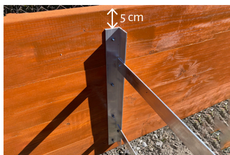
7. Do stredu dlhších strán, dodanými vrátovými skrutkami a maticami, priskrutkujte vzpery. V profil je o 10 cm kratší, ako výška záhona. Priskrutkujte tak, aby začínal aj končil 5 cm od okrajov záhona.
