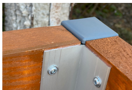
8. Nakoniec na všetky hliníkové rohy nasadíte plastové záslepky. Fošňa mierne presahuje hliníkový profil. A je hotovo! 😊
