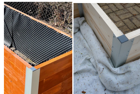
9. Vnútrné steny záhona odporúčame izolovať nopovou fóliou. Pokiaľ záhon stojí na betóne alebo dlažbe, vystelte dno geotextíliou. Predídete vyplavovaniu substrátu medzerou medzi dolnou hranou záhona a podlahou.
