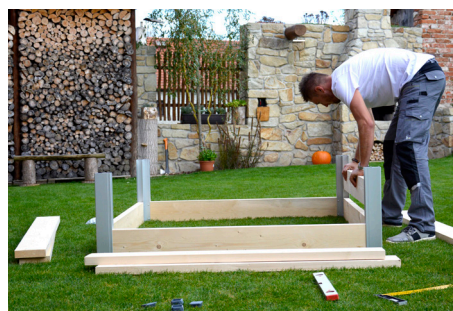
5. Po zostavení prvého radu nasuňte ostatné fošne do zostávajúcich radov. Dbajte na to, aby medzi fošňami nezostali medzery.
